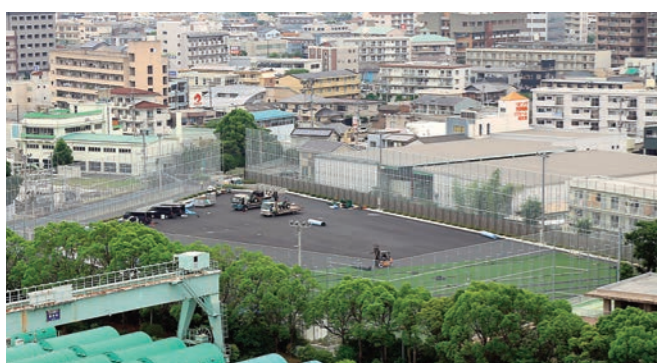
サッカー場建設中
