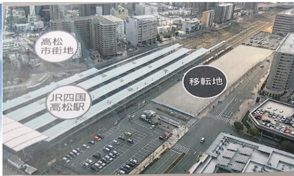
【高松市浜ノ町 高松駅キャンパス建設地】
